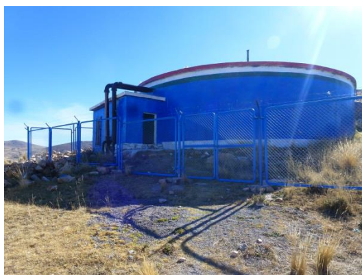
Reservorio existente y en operación R-1 (Vol.: 600 m3) - Sector I
